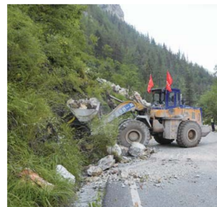
▲8月9日，在四川省道301线九寨沟县境内，中铁一局职工使用大型机械疏通道路。 新华社记者范培坤摄
