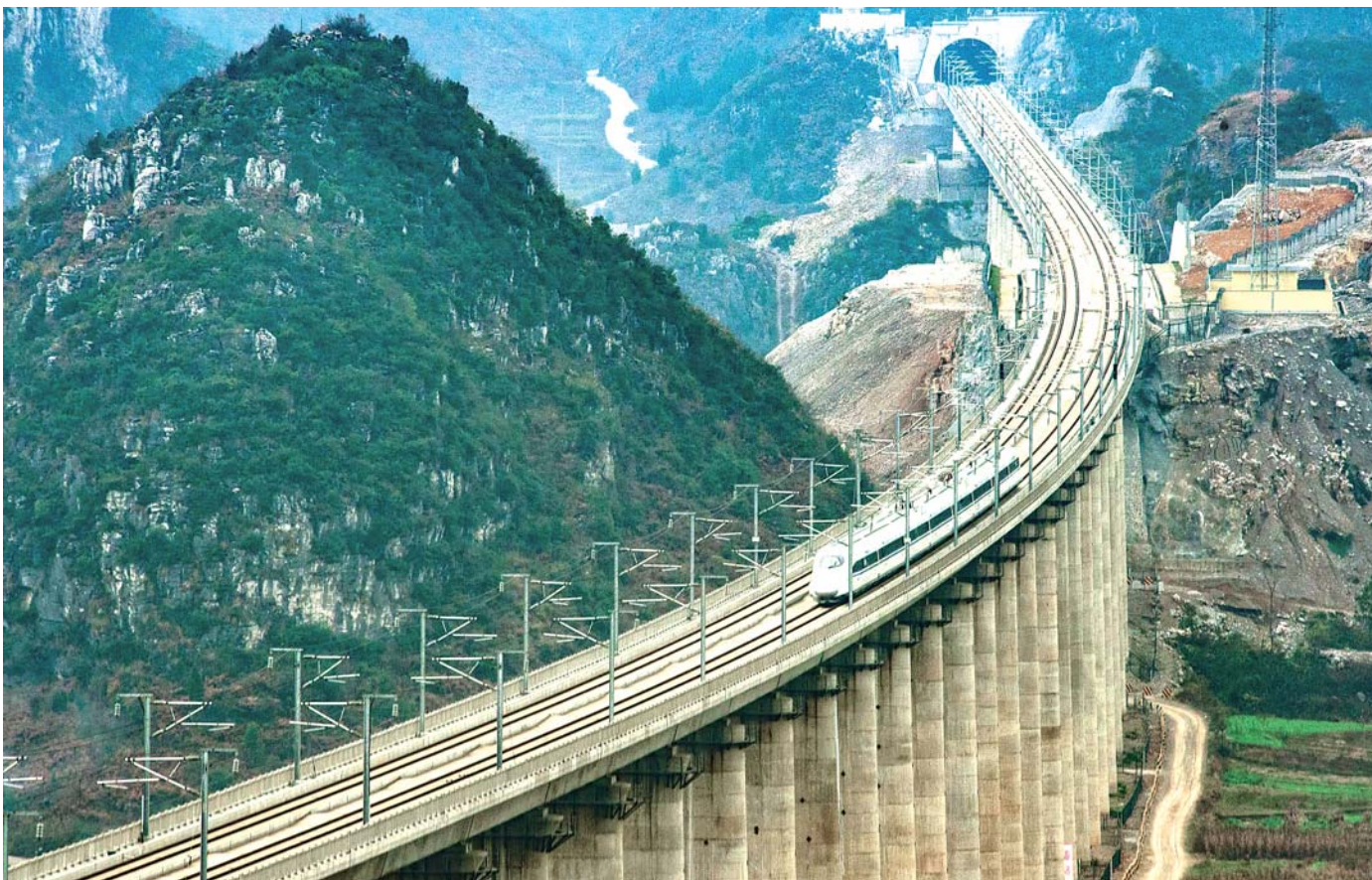
▲由昆明开往贵阳的G4136次列车经过贵州省安顺市境内的水福木寨特大桥（2016年12月28日摄）。近年来，中国高铁继续保持快速发展步伐，“四纵四横”高铁网基本成形，技术成就赢得国际声誉，服务品质不断攀升。中国高铁已经成为一张见证时代发展的名片。 新华社记者刘续摄
