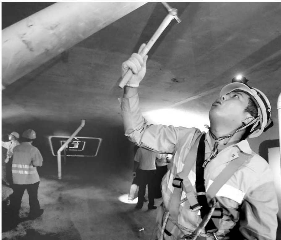
▲7月13日,桥梁检测工在对京沪高铁线路上的丹昆特大桥梁体内进行检测维护。
