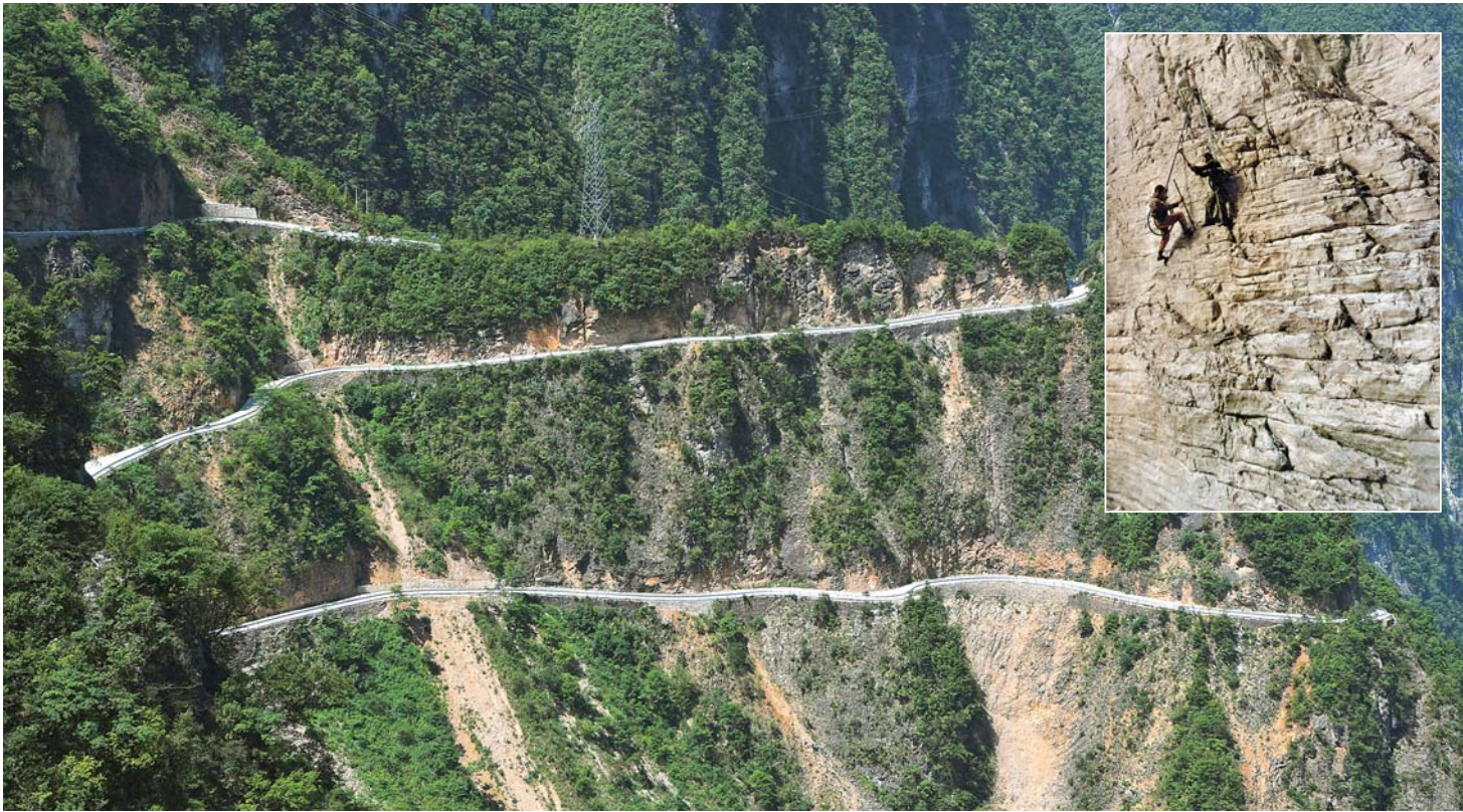
大图：6月7日拍摄的下庄村通往外界的公路。新华社记者王全超摄 小图：参与修路的下庄村村民在悬崖峭壁上打炮眼(资料照片)。新华社发
