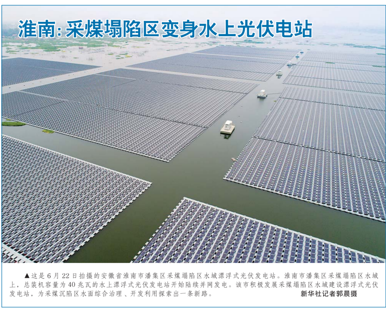
▲这是6月22日拍摄的安徽省淮南市潘集区采煤塌陷区水域漂浮式光伏发电站。淮南市潘集区采煤塌陷区水域上,总装机容量为40兆瓦的水上漂浮式光伏发电站开始陆续并网发电。该市积极发展采煤塌陷区水域建设漂浮式光伏发电站,为采煤沉陷区水面综合治理、开发利用探索出一条新路。 新华社记者郭晨摄
