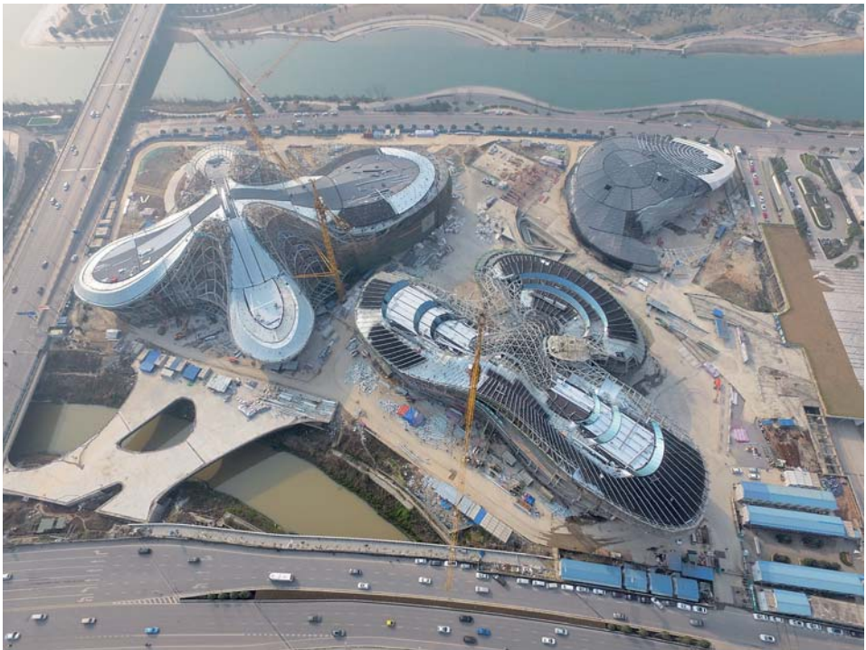
▲这是2月15日拍摄的长沙梅溪湖国际文化艺术中心主体建筑施工现场。 新华社记者 龙弘涛摄
