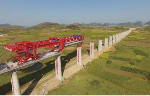
安六铁路进入架梁施工期
