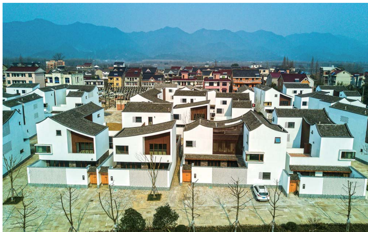
空中俯瞰白墙黑瓦的东梓关村新建回迁房,与其它未改建的农村房屋形成风格鲜明对比(2月17日摄)。近日,一组位于杭州富阳区东梓关村的农村回迁房的建筑组图“点燃”微博,不少网友赞其“如诗如画”,称其为“吴冠中笔下的水墨江南”。该民居群共有46栋房屋,是由政府统一建设的安置房,村民们只需要按照一定的标准购买,就可以从年久失修的老房子里搬入新房,房屋户型面积大约在290平方米至340平方米之间。据设计师介绍,该民居的设计的确受到了吴冠中先生画作的启发,运用白墙黑瓦,错落布局,来体现水墨江南的感觉。在外观上走“写意路线”,对传统要素进行了现代转换,对“杭派民居”的风格进行了抽象表达。据悉,东梓关村位于杭州市富阳区场口镇,是杭州市确立的首批14个“杭派民居”示范村之一,市政府出资予以补助。大天井、小花园、高围墙、人字线等是杭州建筑的传统特色。新华社记者徐昱摄
