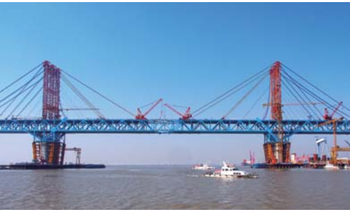
世界最大跨径公铁两用钢拱桥合龙 1月21日，世界最大跨径公铁两用钢拱桥——沪通长江大桥天生港专用航道桥合龙。 新华社记者陈飞摄
