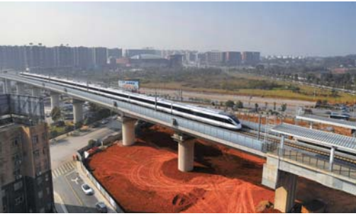
长株潭城际铁路空载试运行 长株潭城际铁路于近日进入空载列车试运行阶段,每日最高开行试验动车组列车27对。 新华社记者龙弘涛摄
