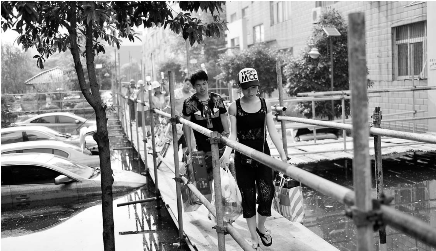
▲7月12日，武汉市南湖雅园小区的居民从栈桥上通过。为保障居民出行，积极应对即将到来的新一轮强降雨，有关部门在这个地势较低的小区搭建起栈桥。
