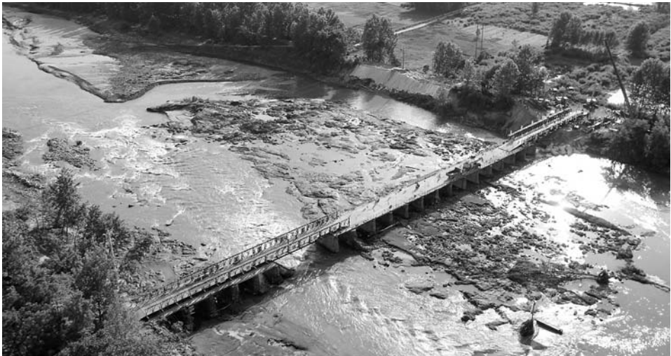
▲7月8日航拍架通后的湖北浠水县叶家湾大桥。当日，经过武警交通二总队六支队官兵连续奋战，两座装配式钢桥成功架通在被洪灾冲断两处的湖北省麻城市浠水县叶家湾大桥上，河对岸丁家寨村恢复了与外界中断长达7天的交通。
