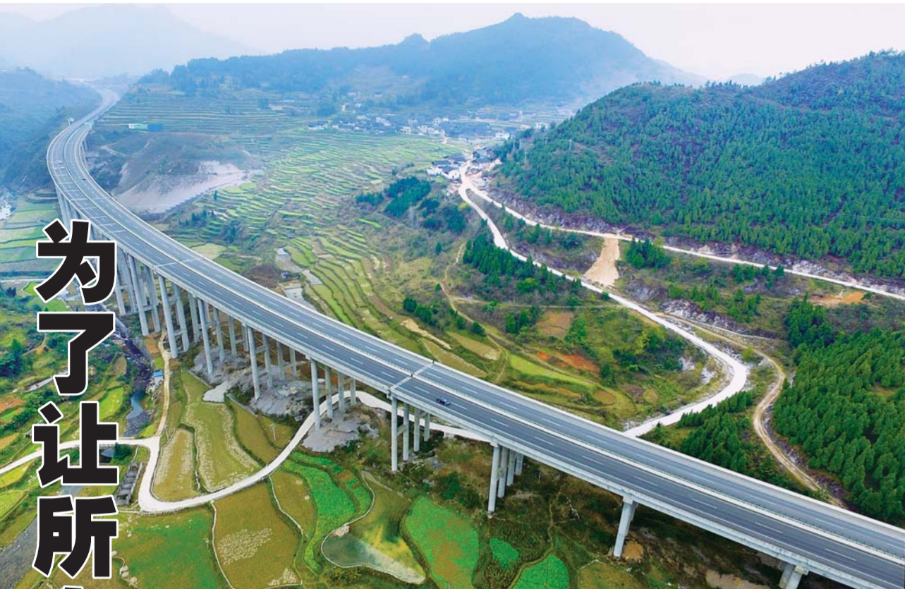
▲厦蓉高速贵州丹寨县羊甲大桥。近年来,贵州实施“县县通高速”计划,高速公路路网建设迅速推进。 新华社发(吴东俊摄)
